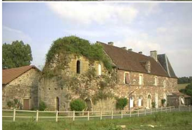
Façade Est (en haut) et façade Ouest (en dessous)
